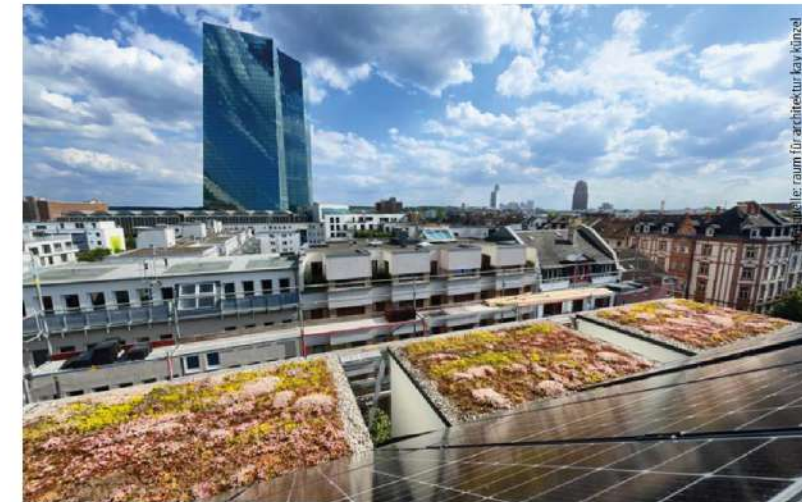
Auf dem Satteldach und der Südwest-Hauswand sind großflächig PV-Module mit einer installierten Leistung von 30 kWp montiert worden, deren Strom sowohl für den Gebäudebetrieb als auch von den Haushalten genutzt wird.
