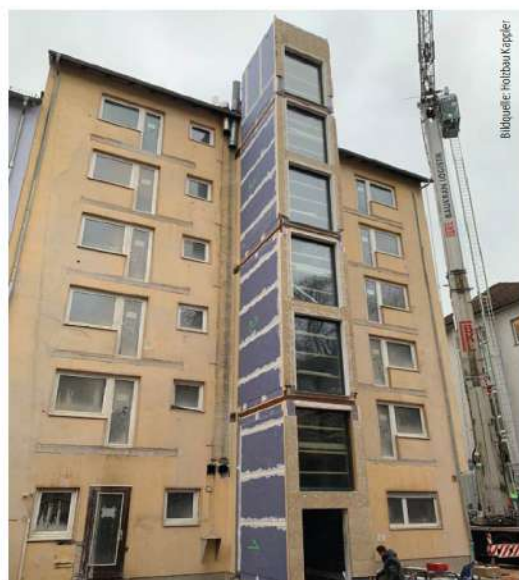
An den Elementstößen wurde der Aufzugsschacht mit der neuen HRB-Wand verbunden. Zudem hat man die Aufzugswände durch Elastomerlager von den neuen Geschosdecken schalltechnisch entkoppelt.
