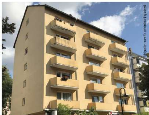
Das unterkellerte Mehrfamilienhaus im Ursprungszustand: Es umfasste Erdgeschoss, fünf Obergeschossen und ein ausgebautes Dachgeschoss und war in einschaliger Massivbauweise aus 24 cm dicken Kalksandsteinen ohne weitere Dämmung errichtet worden.
