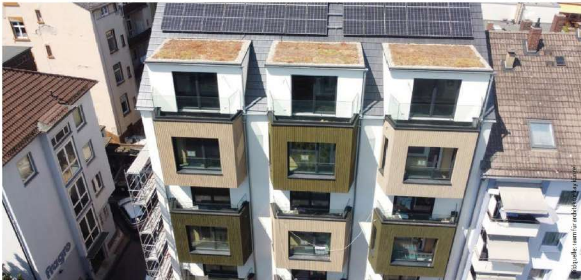
Der Dachstuhl wurde neu aufgebaut, so entstanden drei zusätzliche Wohneinheiten, die an beiden Dachseiten mit insgesamt fünf vorgefertigten Gauben versehen wurden. Deren Dachflächen wurden als Gründach ausgeführt.
