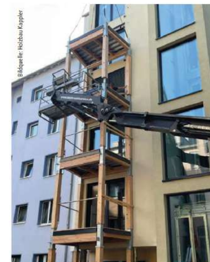
Links und rechts davon hat jede Wohnung einen neuen Balkon erhalten. Diese bestehen aus einer witterungsresistenten Lärchenholz-BSH-Konstruktion der Festigkeitsklasse GL24h mit einem Terrassenbelag aus Douglasienholz.
