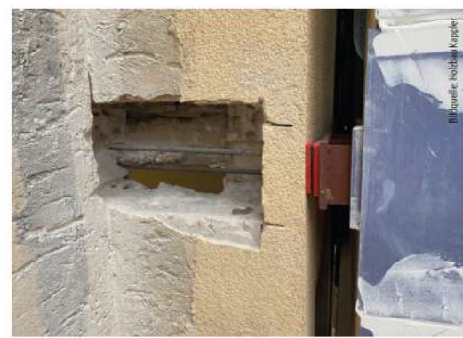
An den Elementstößen wurde der Aufzugsschacht mit der neuen HRB-Wand verbunden. Zudem hat man die Aufzugswände durch Elastomerlager von den neuen Geschosdecken schalltechnisch entkoppelt.
