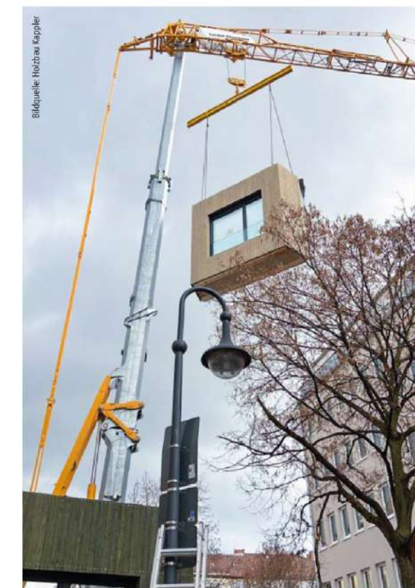
Jede zweite Wohnung hat einen solchen Erker bekommen und auf diese Weise eine eingehauste Wohnraumerweiterung von rund 4 m 2 erhalten.
